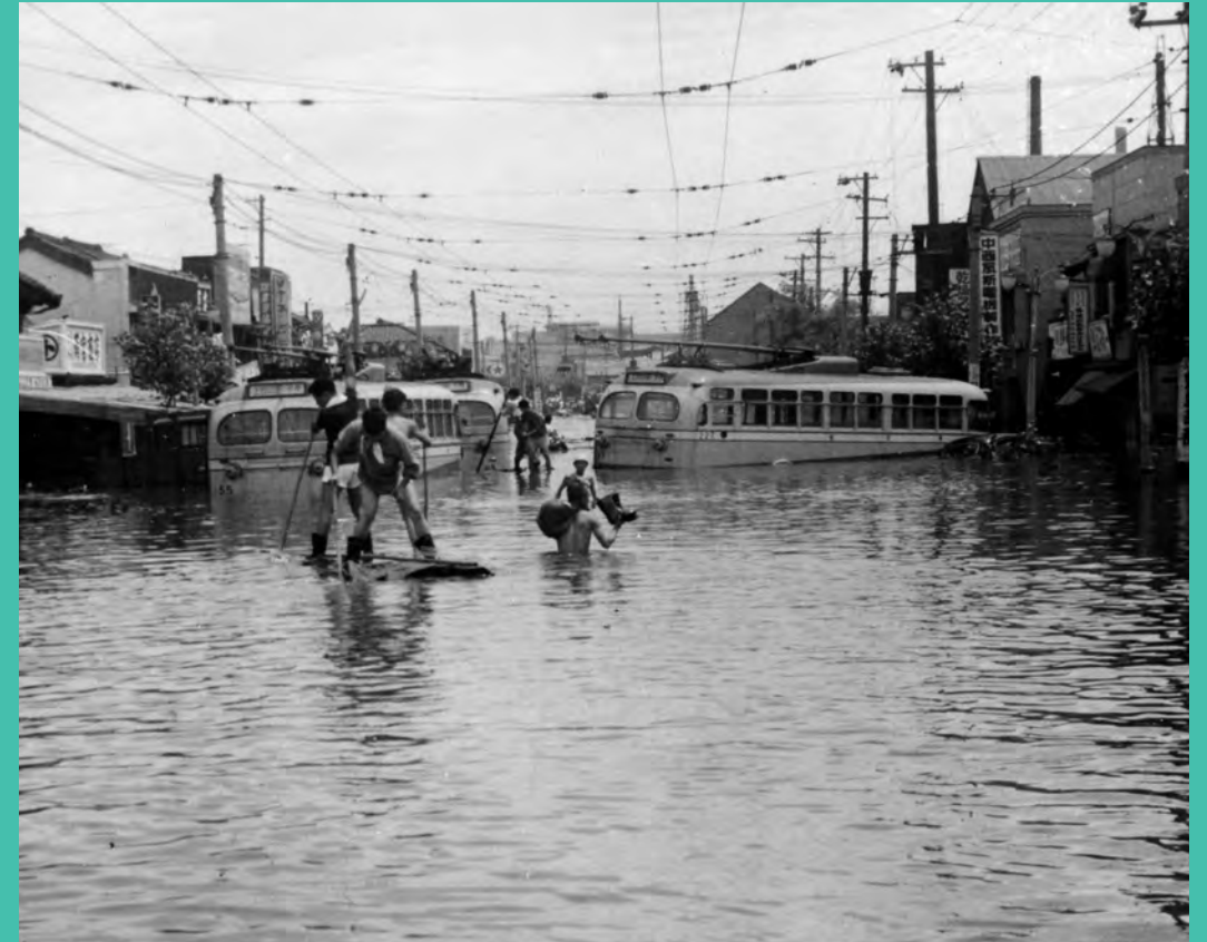
昭和33年台風11号による被害「亀戸9丁目付近」 資料提供元：『まちの記憶と未来展』江東区土木部河川公園課
