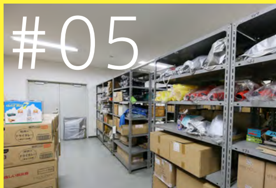
豊洲 IHI ビル 防災倉庫
